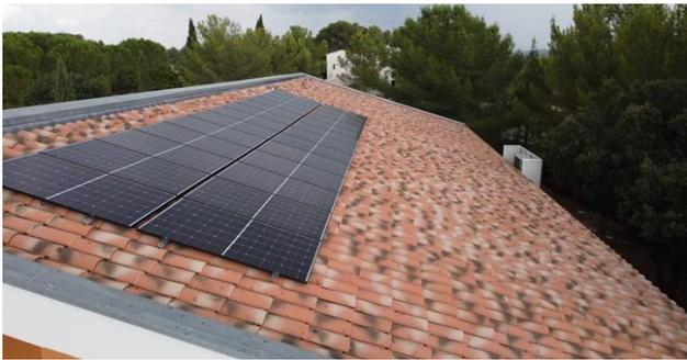
Les panneaux solaires sont installés sur le toit de l'Espace La Pléiade. Cet été, la production instantanée pendant la journée a dépassé les 8 kW, largement au-dessus de nos besoins. Le surplus est revendu à la CESML. Cet équipement devrait réduire grandement notre facture d'électricité. Coût 13 947 € HT
