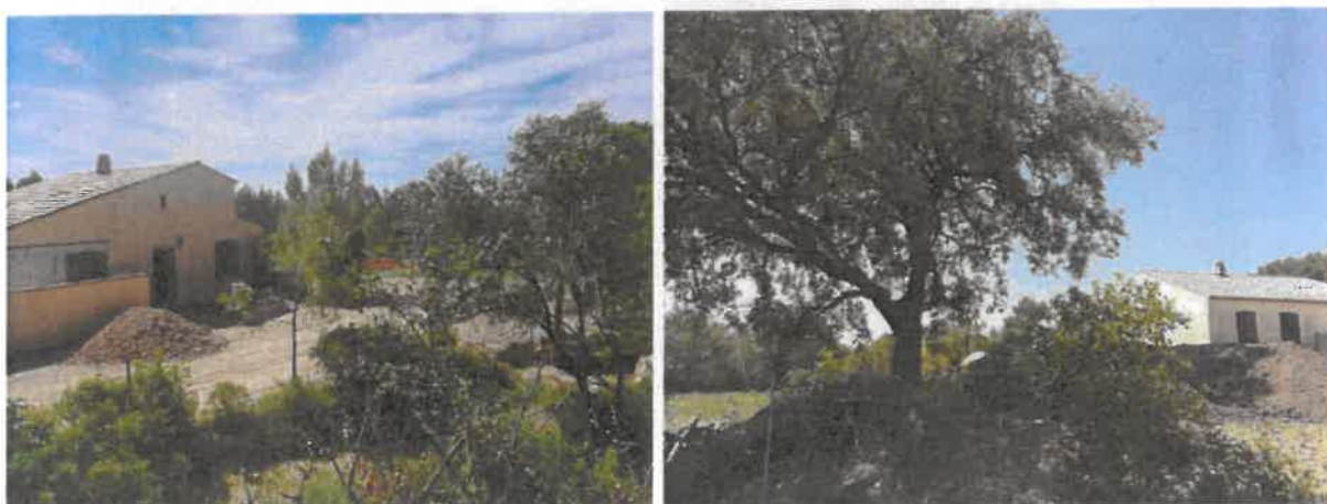
Aperçu des milieux naturels restants autour de l'habitation en cours de construction sur le secteur « Urbain 2 » – CBE, 2018
