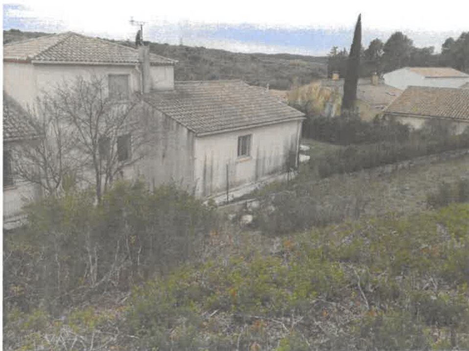
Vue Sud sur les constructions existantes
