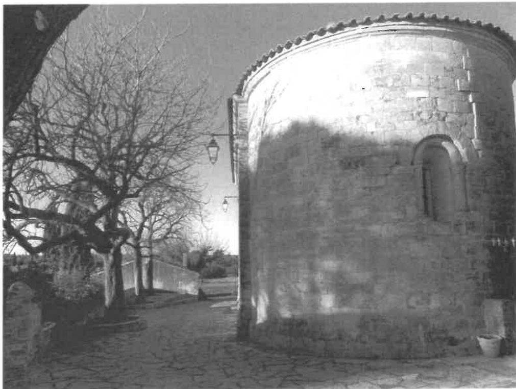
Photo 11. Vue sur l'abside et ouverture sur le paysage
