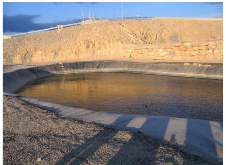
Photo de gauche, le réservoir d'eaux non souillées, qui recueille toutes les eaux pluviales du site, a vocation à être utilisé éventuellement par les services incendies et secours. Sur la droite le bassin des eaux percolées ou lixivats pompées au fond du centre de stockage des déchets et traitées. Elles sont ensuite acheminées par camions citerne à la station d'épuration Maera de l'agglomération de Montpellier.
