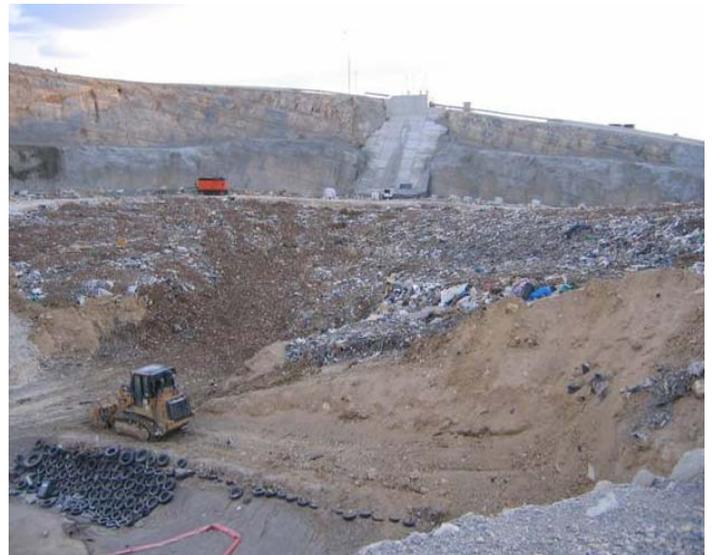
La fosse de stockage : nous apercevons au fond une partie du dispositif d'étanchéité et de drainage sous une couche de pneus qui permettent d'éviter de blesser la barrière active composée de géomembranes et géotextiles. Au fond sur la paroi, l'édifice en béton abrite les galeries de pompage des lixiviats; en pied de talus ces derniers sont drainés par des tranchées et aspirés par des pompes de relevage.
