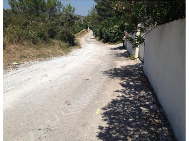
Ci-dessus Chemin du Mas des Violettes, pendant les travaux. Ci-dessous après les travaux, voirie en enrobé et trottoirs avec bordures en béton désactivé de couleur beige. En bas du Chemin, le traitement des eaux pluviales a été réalisé avec des grilles et regards raccordés au réseau pluvial.
