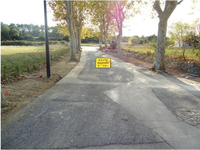
L'entreprise a d'abord réalisé le réseau d'eau pluviale en souterrain sous les futurs trottoirs et a ensuite nivelé toute l'emprise du projet avant d'attaquer l'enrobé et les trottoirs
