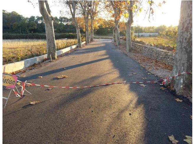
Ici l'enrobé a été mis en place, l'ancien mur de pierres a été remonté et rénové. De l'autre côté, un mur en agglo servira au soutien du trottoir et à un muret en pierres sèches
