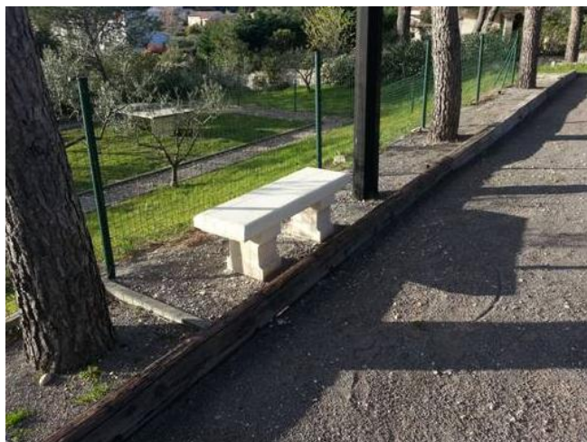
Le banc en pierre qui avait été vandalisé, a été rénové et sécurisé.
