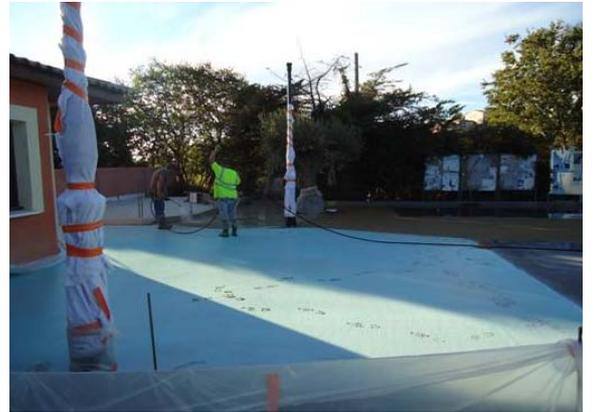
Après livraison et lissage du béton, nettoyage du béton désactivé qui laissera apparaître la couleur naturelle des galets de rivière
