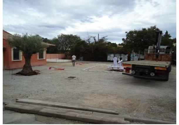
La place après la mise en souterrain des gaines électriques et du drain, du nivelage et de la plantation des oliviers. Les lampadaires sont en cours de livraison
