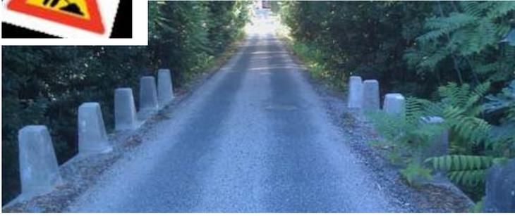
**Chemin du Mas du Lirou :** la rénovation pour la sécurisation du petit pont tel qu'il était à l'origine est terminée. Chaque borne a été récupérée dans le fossé remontée et maçonnée. Les travaux ont été réalisés par la société MC Construction, le coût des travaux est de 1.435,20 €TTC :
