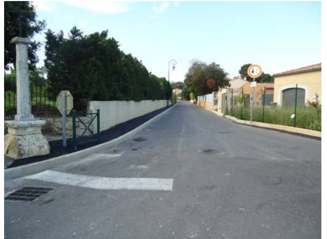
Trottoir Chemin de la Carrierrasse
