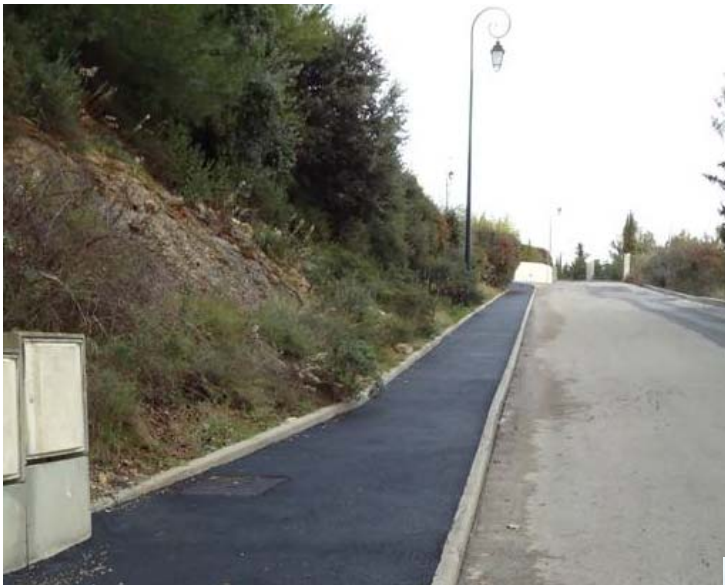
Rénovation du trottoir en enrobé, chemin des Jasses. La partie basse a été consolidée par des petits enrochements afin d'éviter les coulées de terres.
