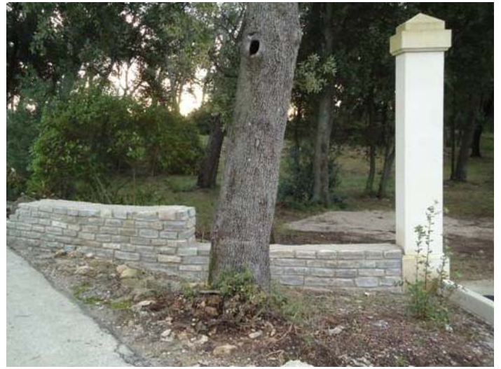
Bois communal : Les premiers mètres du mur de pierres qui clôturera à terme l'ensemble du parc communal, permettent de se faire une idée de l'ensemble.
