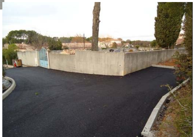
Rénovation de la place du cimetière avec aménagement d'un parking le tout en enrobé avec des bordures.
